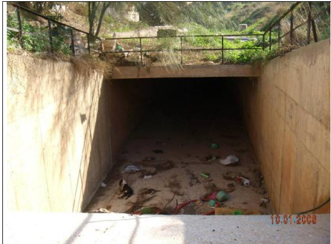
Fotografía 2 – La embocadura tiene una dimensión importante: 5,00 x 3,00 m.
