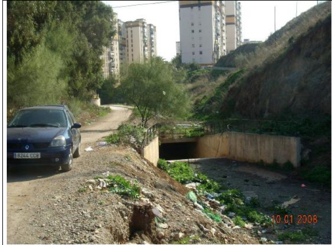
Fotografía 1 – Vemos en primer plano la embocadura del embovedado del arroyo, detrás los edificios de la barriada de la Palma.
