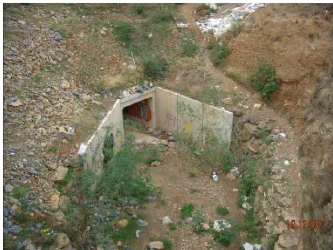
Fotografía nº 3. - Mirando, desde la misma posición hacia aguas abajo vemos la embocadura del marco rectangular de 3,00 x 3,00 m, que cruza por debajo de la autovía que circunvala Málaga.
