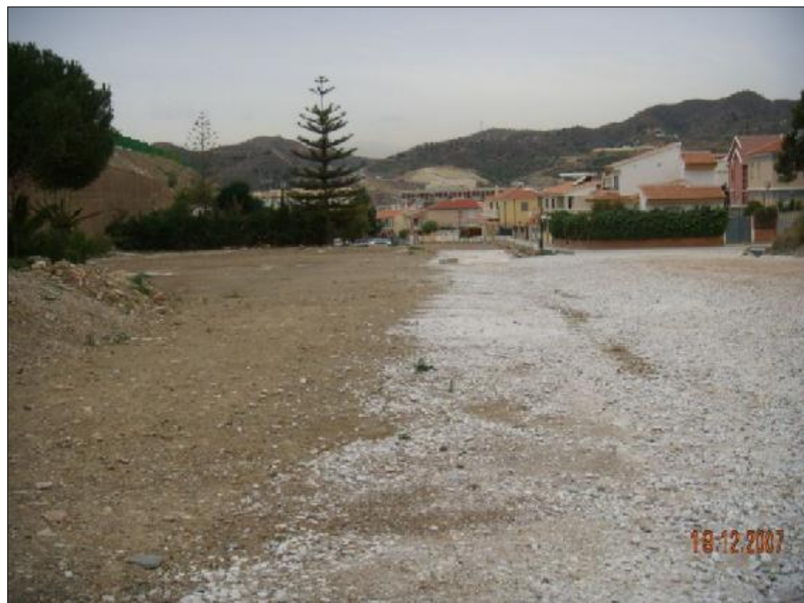
Fotografía nº 15. - Mirando hacia la zona por la que debe discurrir el encauzamiento no se observa ningún elemento de evacuación de pluviales.
