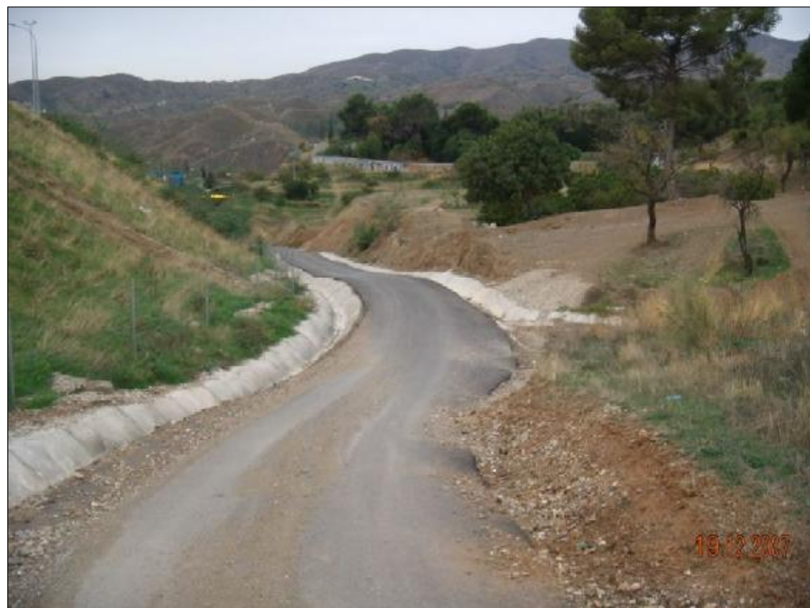
Fotografía nº 7. - Vamos a regresar a la zona sur de la autovía y lo hacemos por el vial que muestra la fotografía en el que los únicos elementos de desagüe longitudinal son las cunetas revestidas que aparecen a ambos lados.
