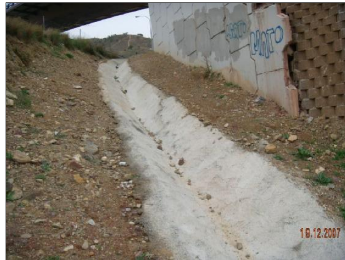
Fotografía nº 14. - A la arqueta, a la que nos referíamos en la fotografía nº 10, llega la cuneta revestida que ahora observamos.
