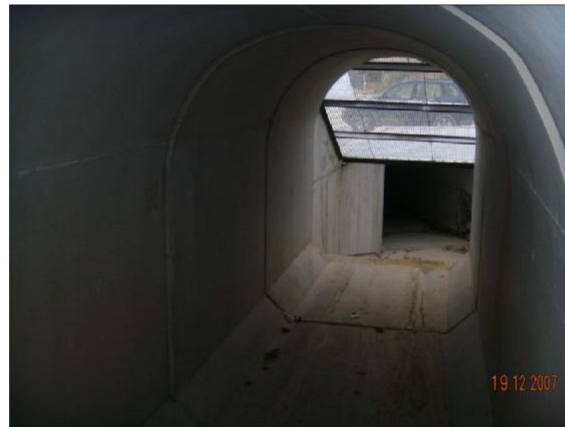
Fotografía nº 12. - Hacia aguas abajo continua la tajea que termina en un arquetón tapado con un tramex metálico. Hacia aguas abajo, desde ese punto, observamos la existencia de un marco rectangular.
