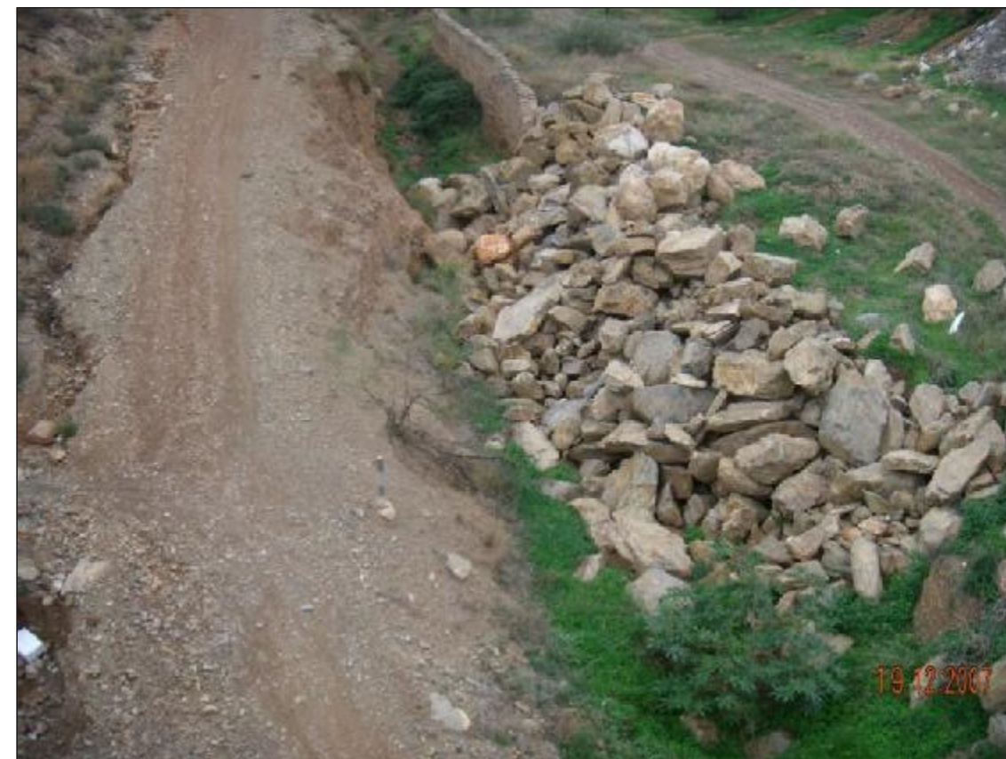
Fotografía nº 2. - Situados sobre el acueducto miramos hacia aguas arriba y vemos el cauce que, inexplicablemente, se encuentra taponado con la escollera que muestra la fotografía.
