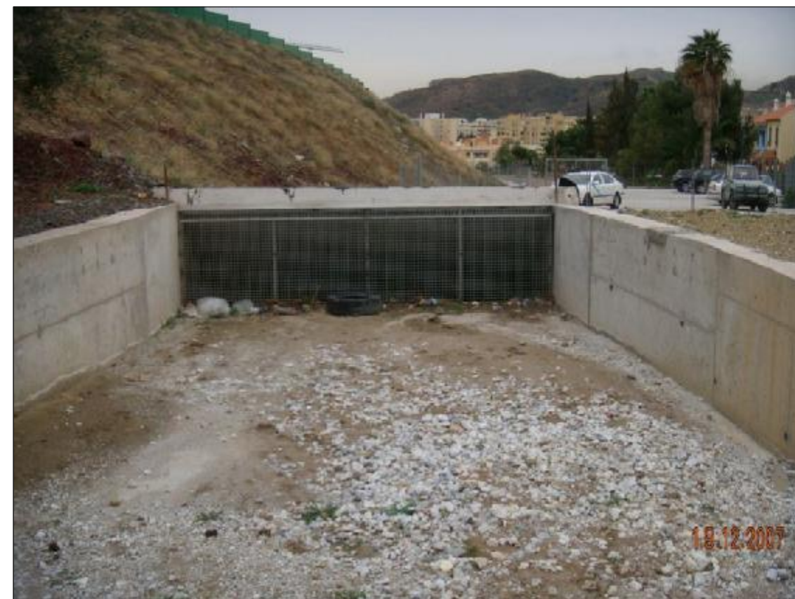
Fotografía nº 16. - A poca distancia del punto en el que tomamos la anterior fotografía vemos este potente elemento de captación de pluviales que ahora no tiene sentido; entendemos que estaría construido antes de que se acometieran las obras que antes hemos mostrado.
