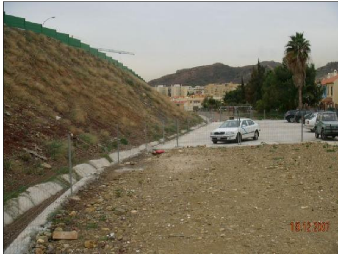
Fotografía nº 17. - Hacia aguas abajo ya no se observa ningún elemento de evacuación de pluviales si exceptuamos la cuneta revestida existente al pie del vial que recientemente se ha construido.
