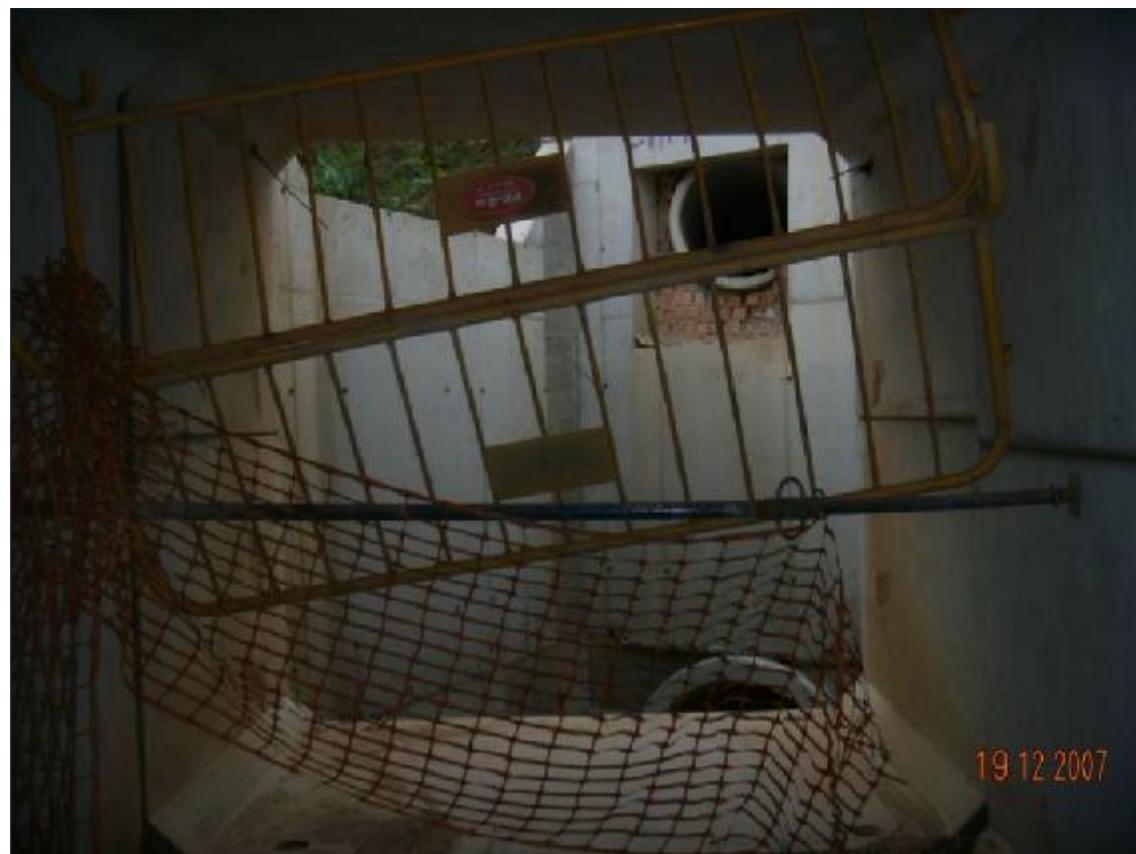
Fotografía nº 5. - Hemos entrado en el marco y transitado por él hasta su límite inferior. Nos sorprenden unas vayas y un puntal que habría que retirar. Finalmente observamos un gran arquetón en el que vemos una tubería superior que realizará algún vertido y una tajea que dará continuidad a la evacuación.
