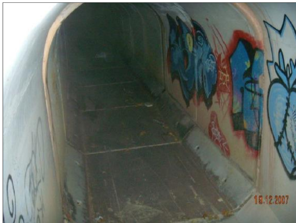
Fotografía nº 11. - Hacia aguas arriba vemos la misma tajea que mostrábamos en la fotografía nº 6.
