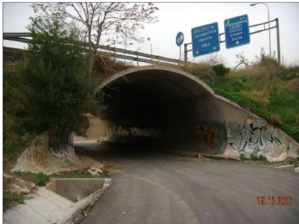
Fotografía nº 9. - Esta es la obra de paso bajo la autovía. Verificamos que el único elemento de desagüe existente en este entorno es el que da continuidad a las cunetas.
