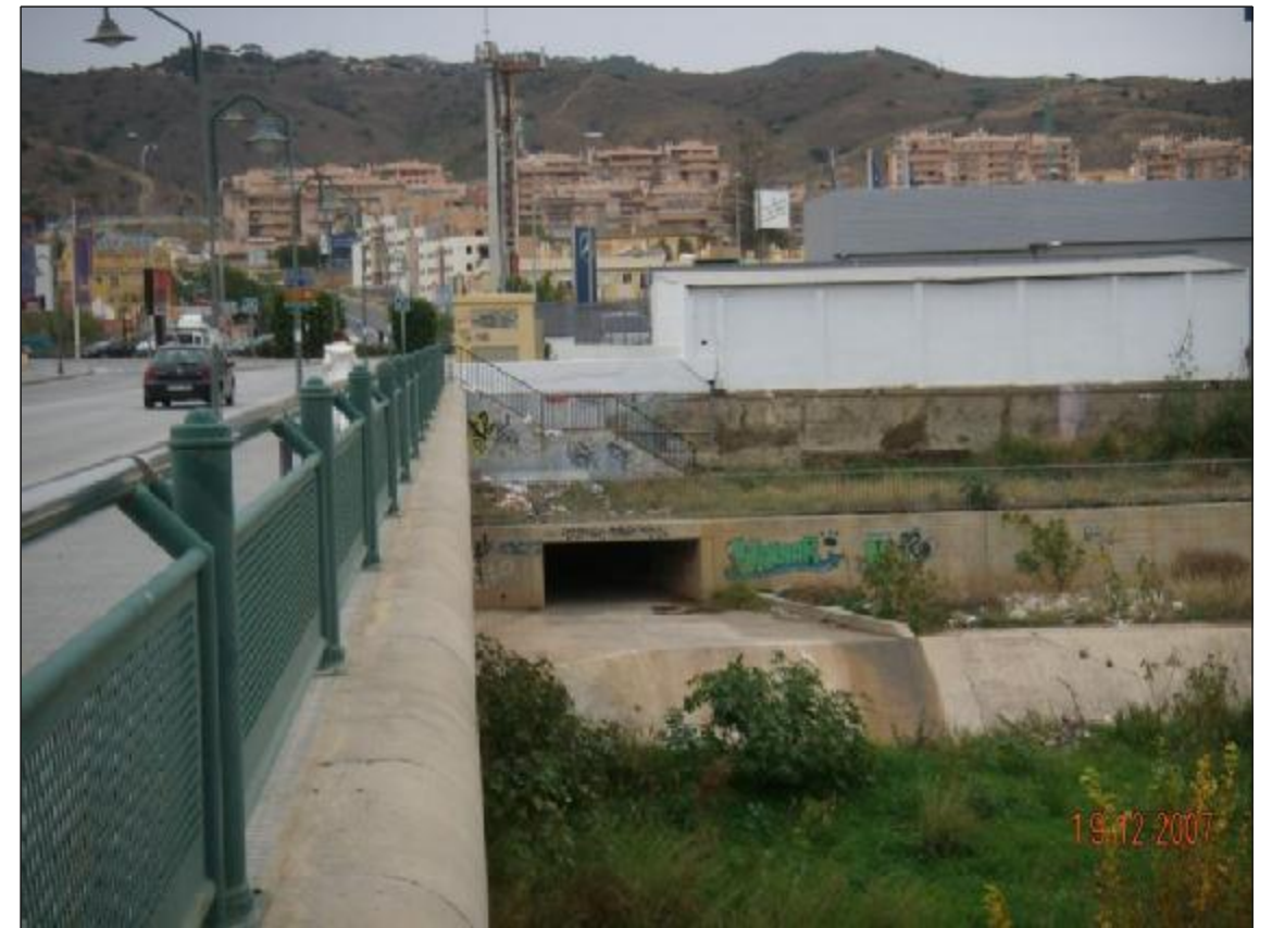
Fotografía nº 18. - Desde la margen izquierda del Guadalmedina mostramos, en la otra margen, lo que entendemos debe ser el elemento final de desagüe del arroyo Sastre.
