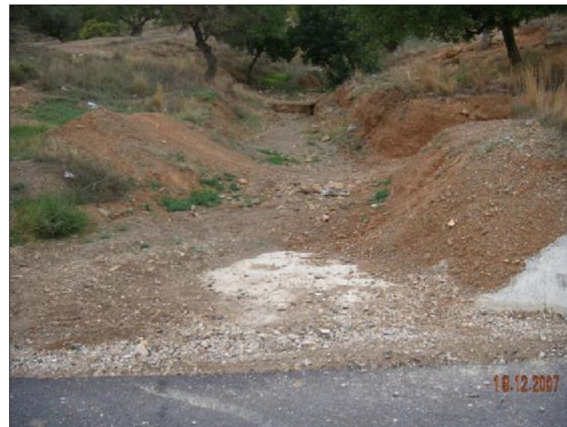
Fotografía nº 8. - Existen pequeños cauces transversales al vial, como el que mostramos, cuya escorrentía discurre por las cunetas antes comentadas.
