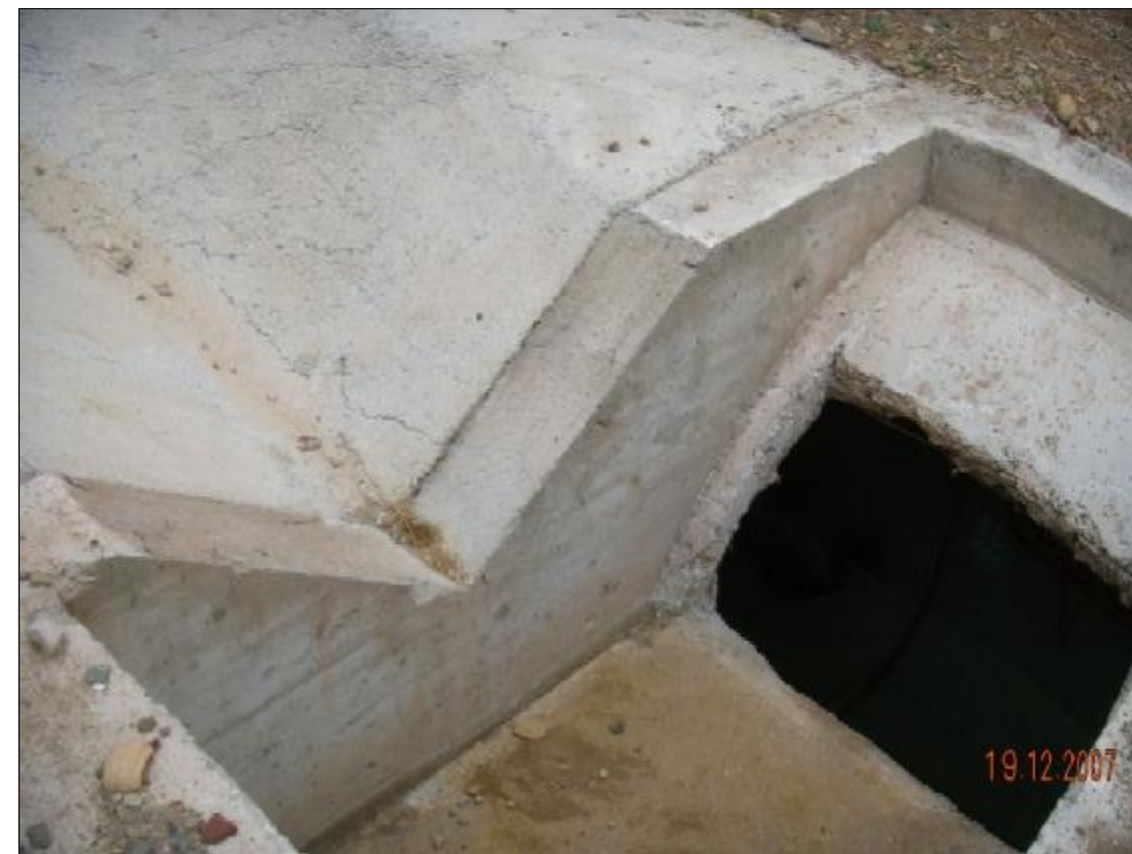
Fotografía nº 10. - En la zona sur de la autovía es difícil mostrar con claridad el discurrir del encauzamiento. Por el agujero que muestra la fotografía hemos introducido nuestra cámara y hemos tomado las dos fotografías siguientes:
