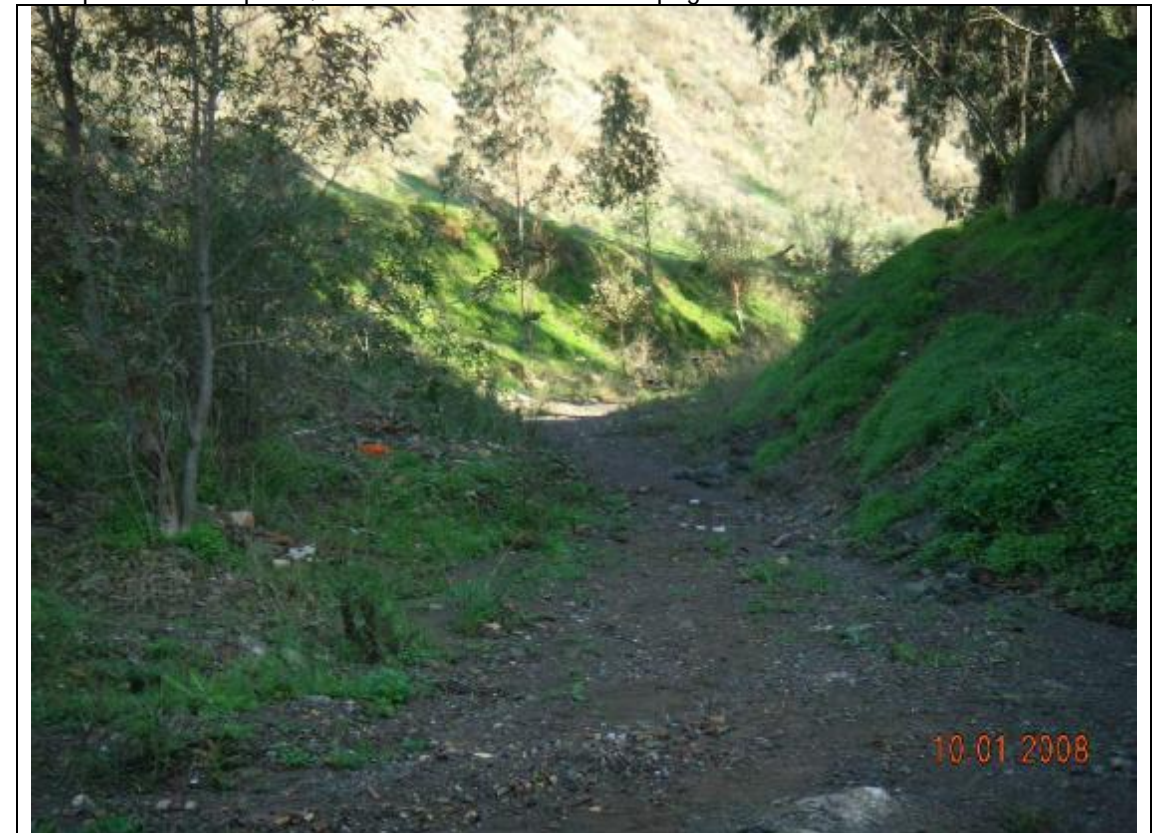
Fotografía 4 – Desde la embocadura hasta el punto en el que hemos tomado estas fotografías el cauce presenta un aspecto semejante al que reproducimos.
