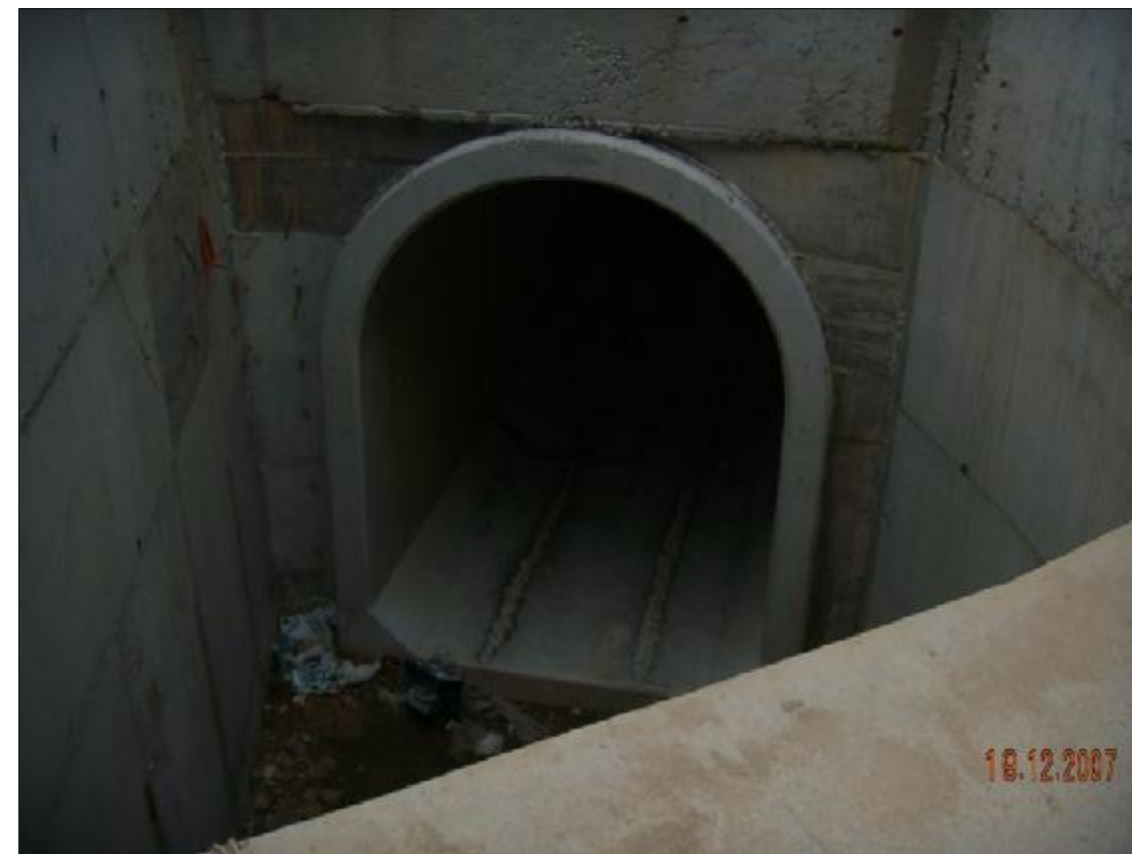
Fotografía nº 6. - Nos acercamos y mostramos con más detalle la referida tajea.
